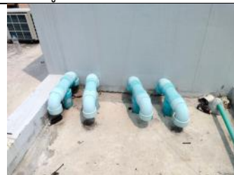
รูปที่ ผ7.48 ท่อระบายก๊าซมีเทน
