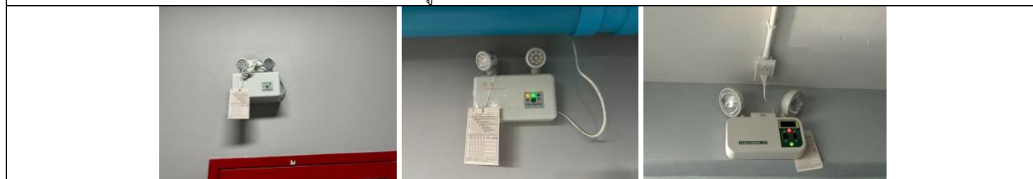
รูปที่ ๗7.43 ไฟฟ้าส่องสว่างฉุกเฉิน
